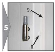
**Schritt 8:** Bohrung wieder mit Abdeckkappe verschließen. **Schritt 9:** Dichtung eindrücken.
