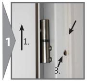
**Schritt 1:** Türblatt aushängen. **Schritt 2:** Dichtung im Bandbereich vorsichtig lösen (falls nötig).
