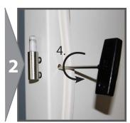
**Schritt 4:** Mit passendem Inbusschlüssel die Klemmschraube in Drehrichtung <u>links</u> lösen.
